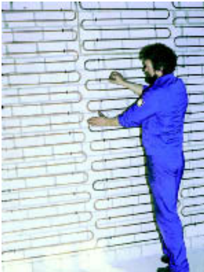
Рис. 5.19 Монтаж секций труб HYROPLAN®
