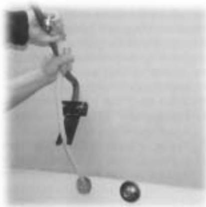
Рисунок 57: Замена поврежденной трубы
