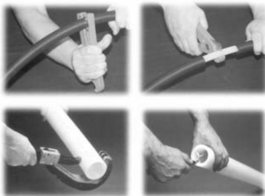
Рисунки 34-37: Способы разрезания труб
