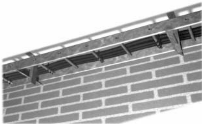
Рисунок 28: Wirsbo-PEX «труба в трубе» на полке предохранит трубы от скопления грязи на их поверхности
