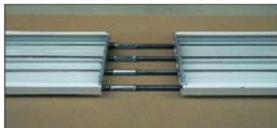
Рис.81 Свести модули таким образом, чтобы трубы плотно прилегали друг к другу.
